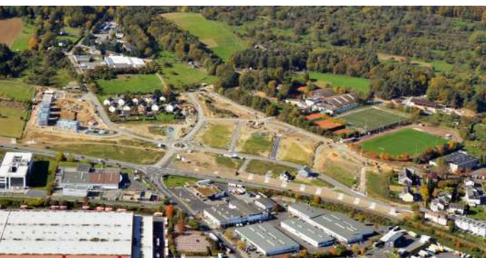
Neubaugebiet „Die Sang“ mit Geschosswohnungsbau
