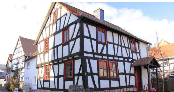
Dorfprägende Bausubstanz in den Ortskernen
